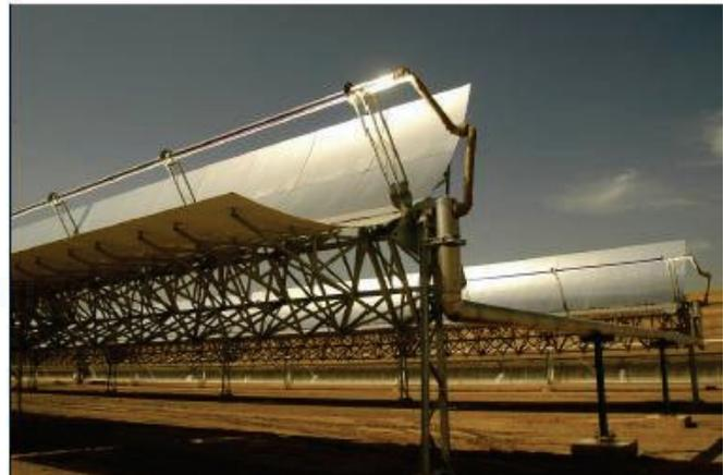
Figura 24. Colectores Cilindro Parabólicos y sus Características
